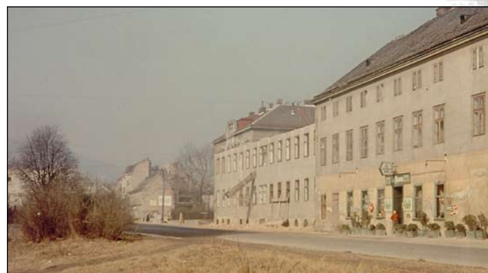
Das Spitzerhaus und eines der Kümmerlhäuser während des Abbruchs des Spitzerhauses 1958. Zu sehen ist rechts noch das Gasthaus Leopold Schröder und teilweise unverbaute Gründe südlich der Auhofstraße.
