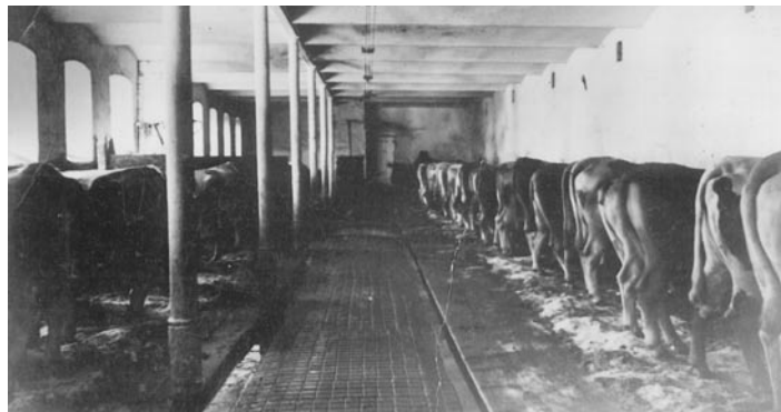
Der geräumige Kuhstall der Familie Wimpissinger. Die Eisensäulen und das Tonnengewölbe sind auch heute noch gut sichtbar.
