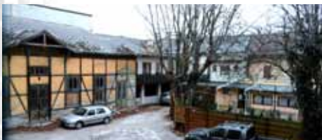
Ein historisches Foto (oben, © Bezirksmuseum Hietzing) und ein aktuelles Foto (© Rudolf Wawra) vom Weinbrunnen in der Auhofstraße 205. Das aktuelle Foto vom 4.2.2012 zeigt den Innenhof mit dem einstigen Tanzsaal hinter dem Hotel an der Lilienberggasse (der Fachwerkbau links) und die Rückseite des Restaurants an der Auhofstraße mit Gastgarten (rechts).
